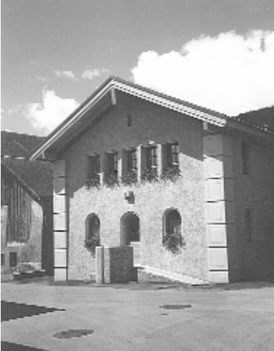
La maison bourgeoise de Montana, après sa rénovation en 1996
