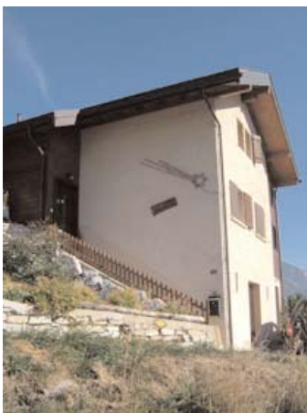
La maison de Corin dans laquelle a vécu le couple jusqu'en 1988.
